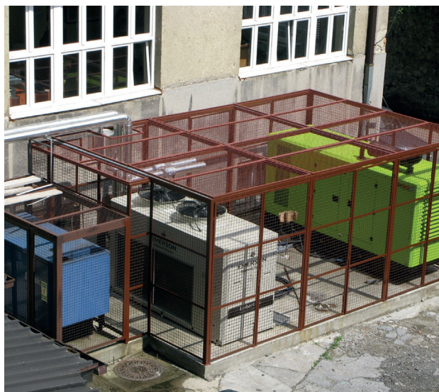
Слика 3. Клима систем и агрегати за подршку серверских сала у РГЗ
